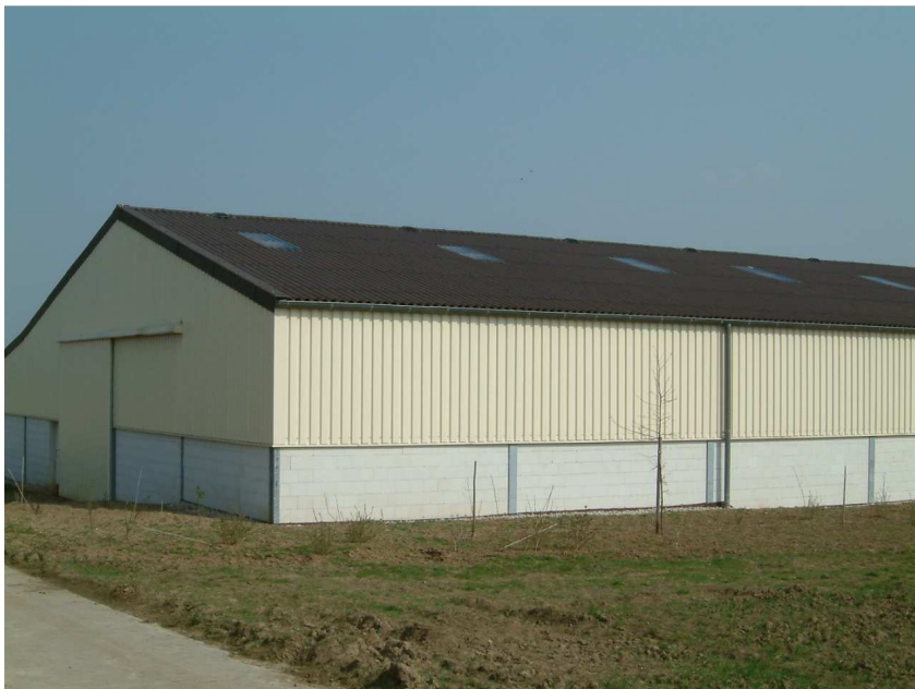
Nachteilig bei einer Fassade aus industriell hergestellten profilierten Blechen ist die geringe Widerstandsfähigkeit gegenüber einer mechanischen, stoßartigen Belastung.
