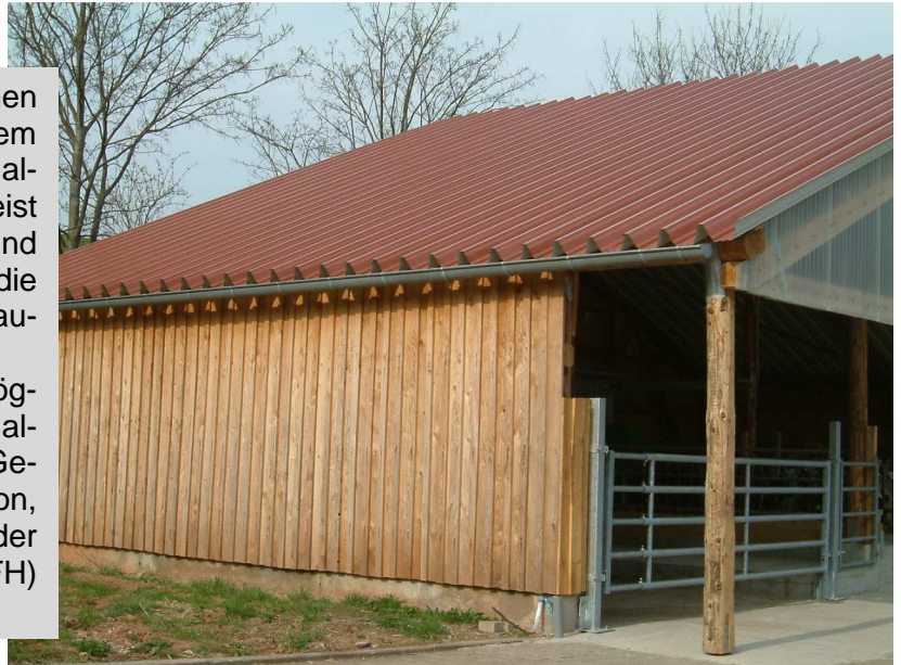
Die Verwendung einer Holzverschalung als Außenwandmaterial garantiert eine natürliche, optisch ansprechende, strukturierte Fassadengestaltung
